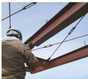
現場作業風景
