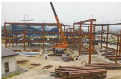
こもれびの森A・B新築工事
