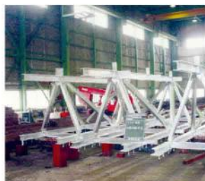
製品組立状況
